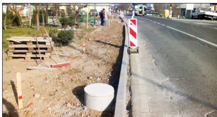
Izgradnja pločnika v Hajdošah
