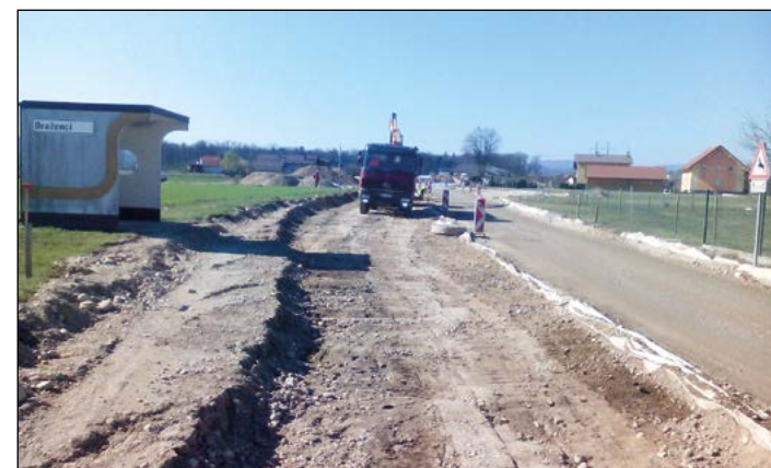
Izgradnja pločnika v Dražencih
