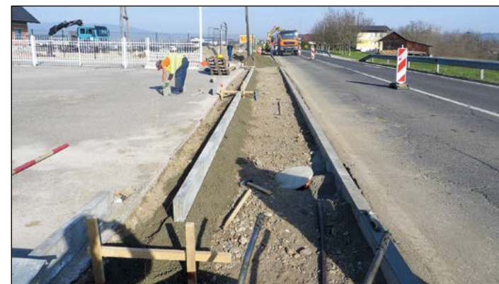
Izgradnja pločnika v Hajdošah
