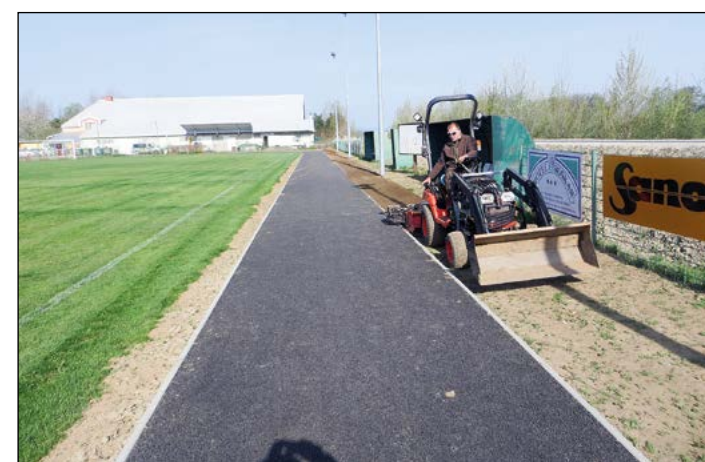
Izgradnja atletske steze v Hajdošah
